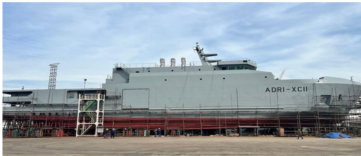
Proses Finishing Pembangunan Kapal ADRI VCII di galangan kapal
